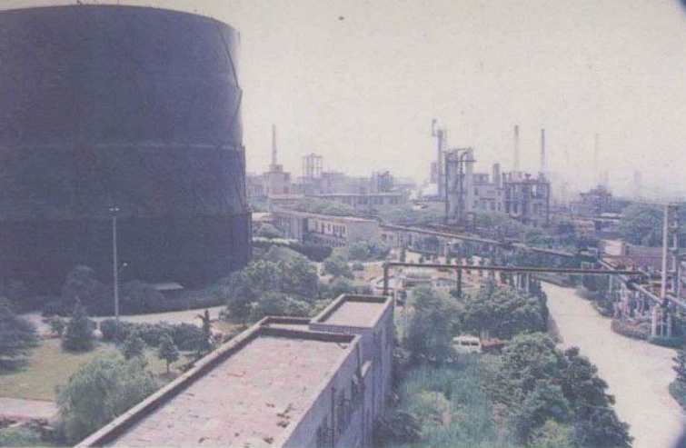
16. 无锡市焦化厂54000M 3 煤气储气柜
