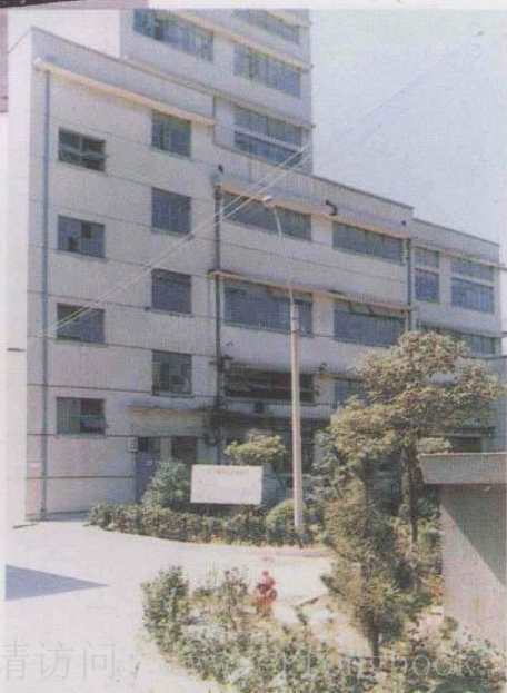
30. 红星化工厂7千吨 蒽醌法双氧水生产大楼
