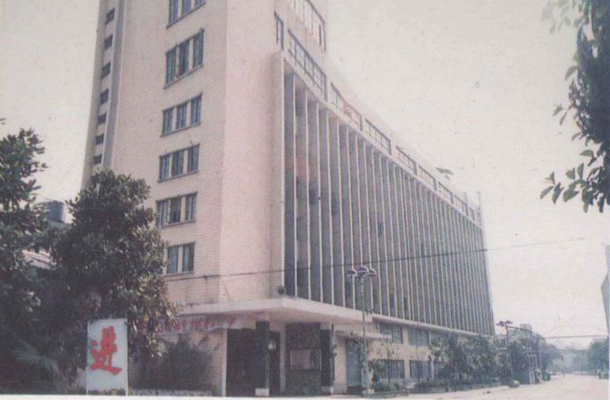
14. 无锡市造漆厂年产2000吨色漆大楼
