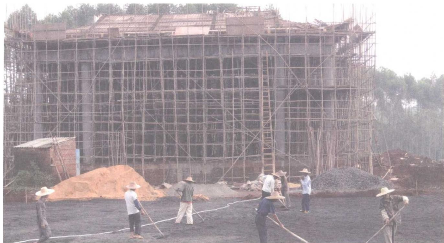
建设中的足荣村广场大戏台
