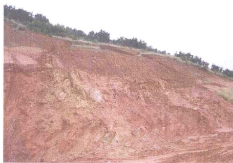
图 1-13 滑坡破坏
