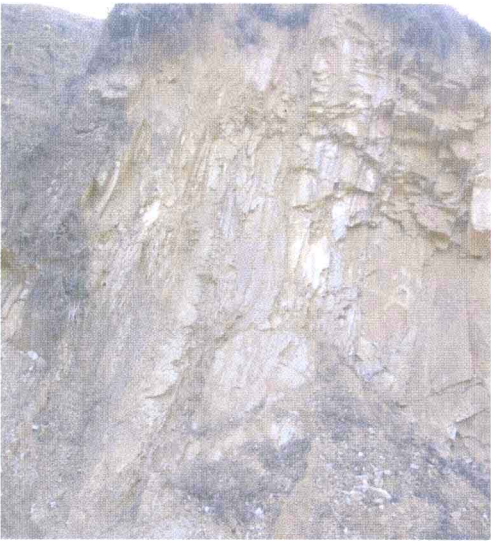
图 1-3 风化剥落
