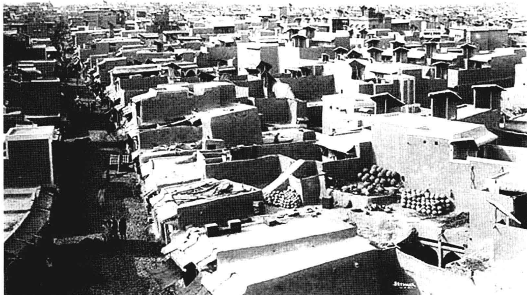
图 1-6 海得拉巴民居捕风窗 图 1-7 海得拉巴民居的土坯泥砖墙体
