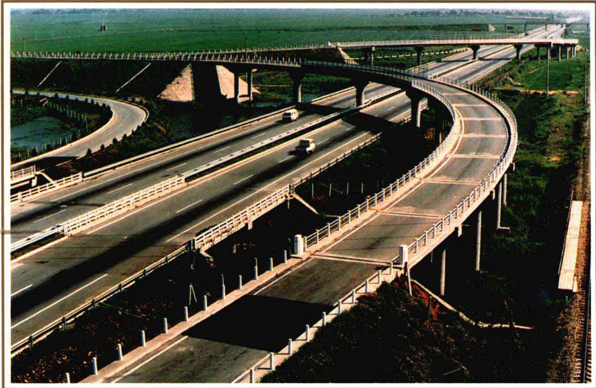
互通式立交桥
