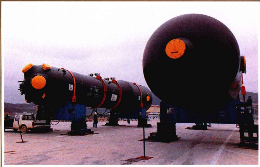
大亚湾核电站设备安装
