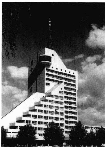
三门峡市黄金管理局办公大楼
