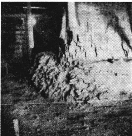
图7 二窟塔柱加固工程（原状）
