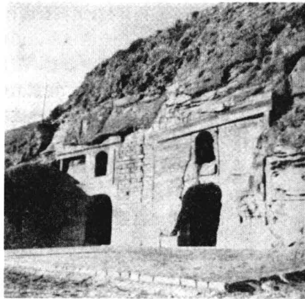
图2 前壁加固工程（加固后）
