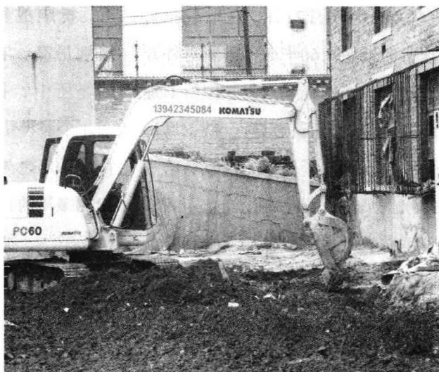
挖掘机在平整运动场
