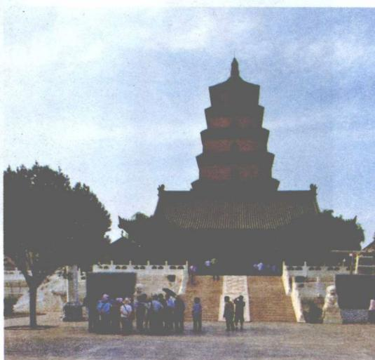
大雁塔是楼阁式砖塔，塔通高64.5米，塔身为七层，塔体呈方形锥体，由仿木结构形成开间，由下而上按比例递减。塔内有木梯可盘登而上。每层的四面各有一个拱券门洞，可以凭栏远眺。整个建筑气势宏伟，造型简约沉稳，格调庄重古朴，比例协调适宜，是保存比较完好的楼阁式塔。除此之外，大雁塔还是一个很好的观景点，在塔内可俯视西安古城。
