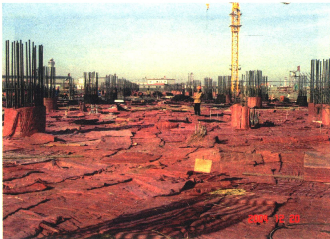
6. 机场 T3B 航站楼底板混凝土双重保温
