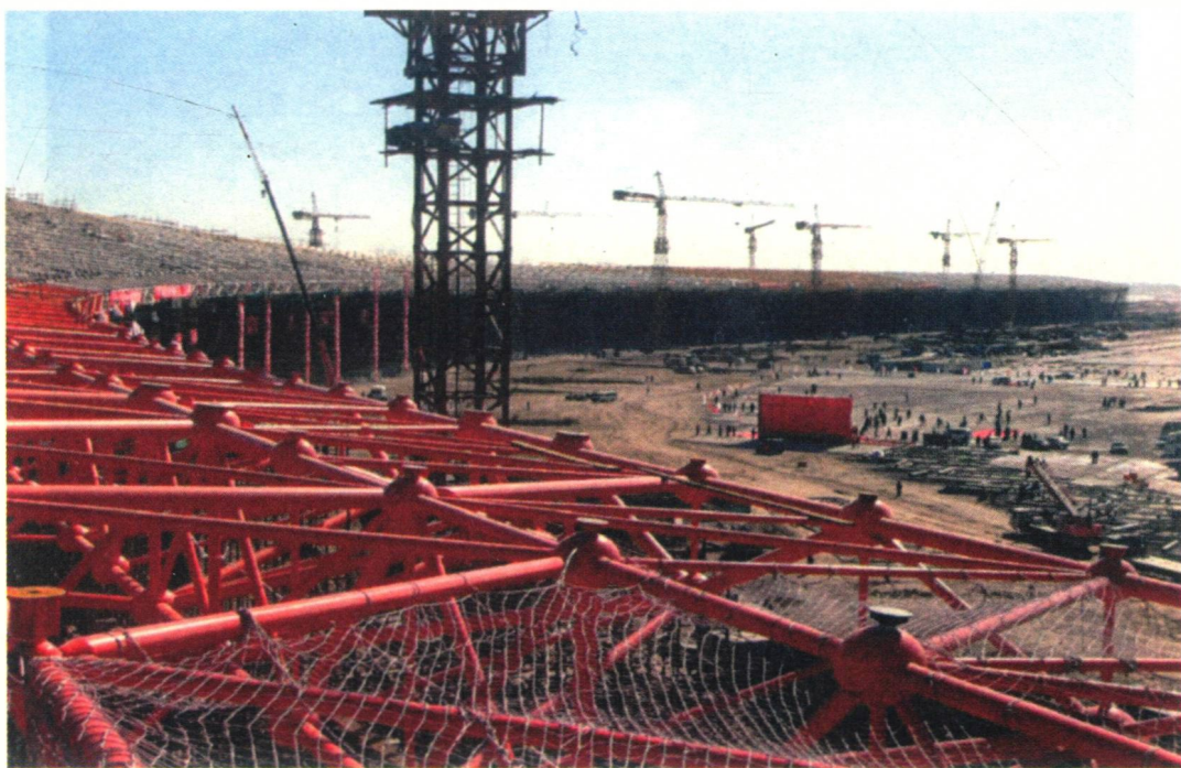
5. 机场 T3B 航站楼边桁架优美曲线
