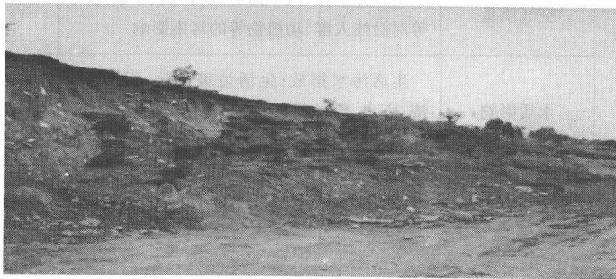
图 1-1-3 坡面坍塌案例
