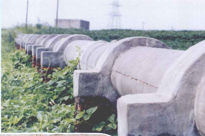
▶ 节水灌溉管渠
