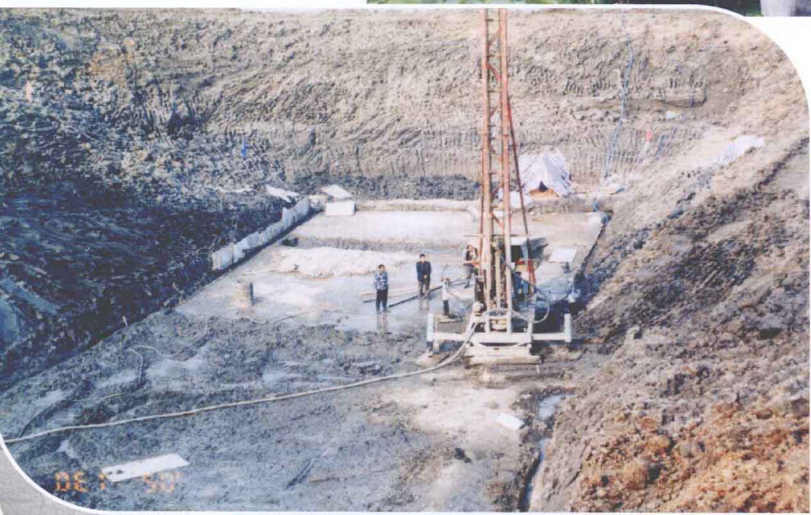
▶ 西湖补源工程喷桩施工
