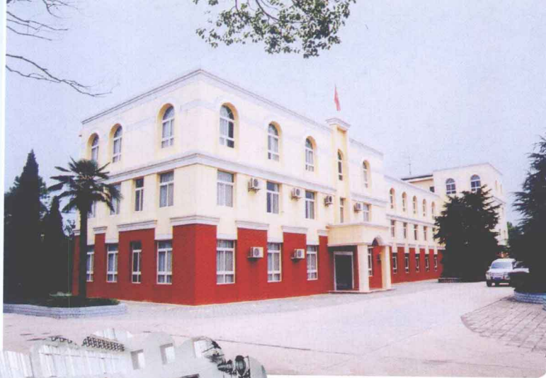
东湖泵站办公楼
