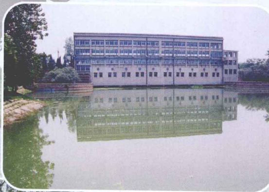
东湖泵站泵房
