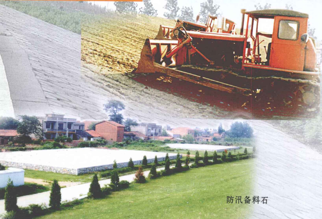
▼ 江堤整险加固工程堤身加 培施工现场
