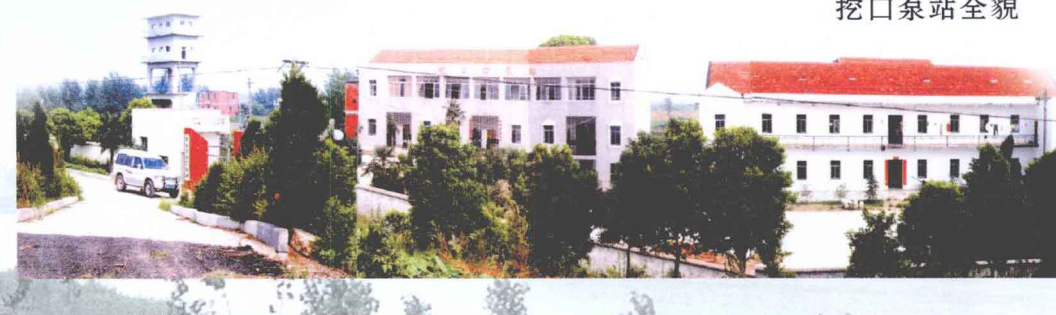
挖口泵站全貌
