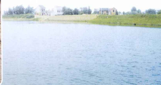
▼ 整险加固后的凤凰水库
