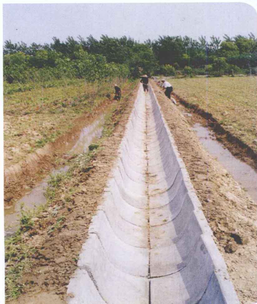
◀ 我区 U型防渗 明渠施工 现场
