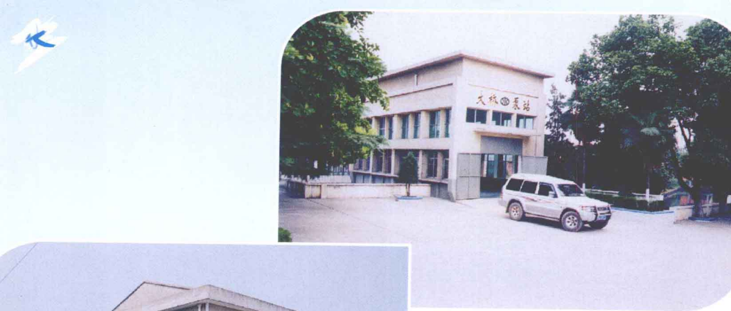
▲ 蔡甸大桥泵站
