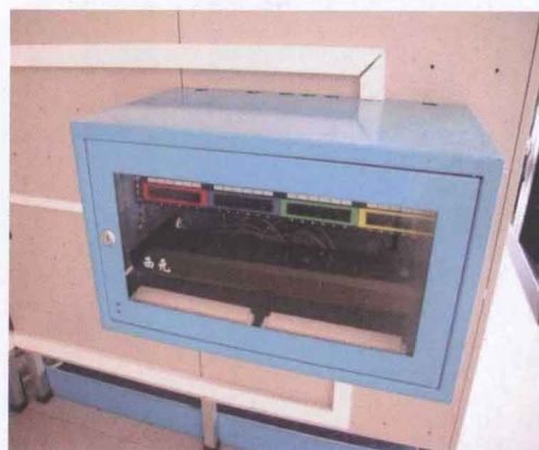
图 3-18 西元壁挂式网络机柜
