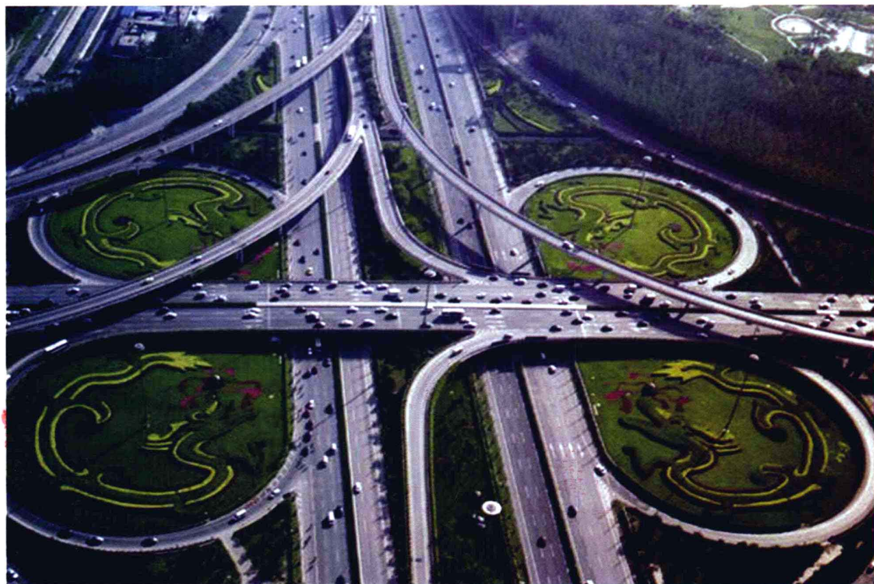
北京四元桥立交枢纽
