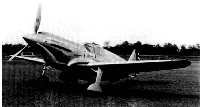
可以看出XP-46引擎罩下方的進氣口設計思想繼承自P-40系列，和北美公司的設計差別甚多。
