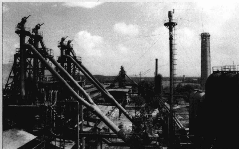
▲1986年建成的桂林铁合金总厂一角
