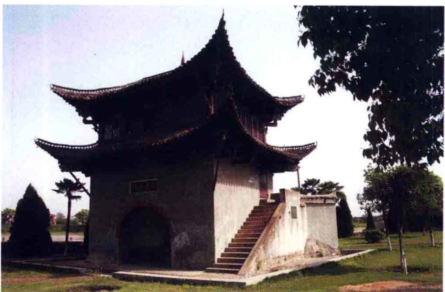
永丰县状元楼
