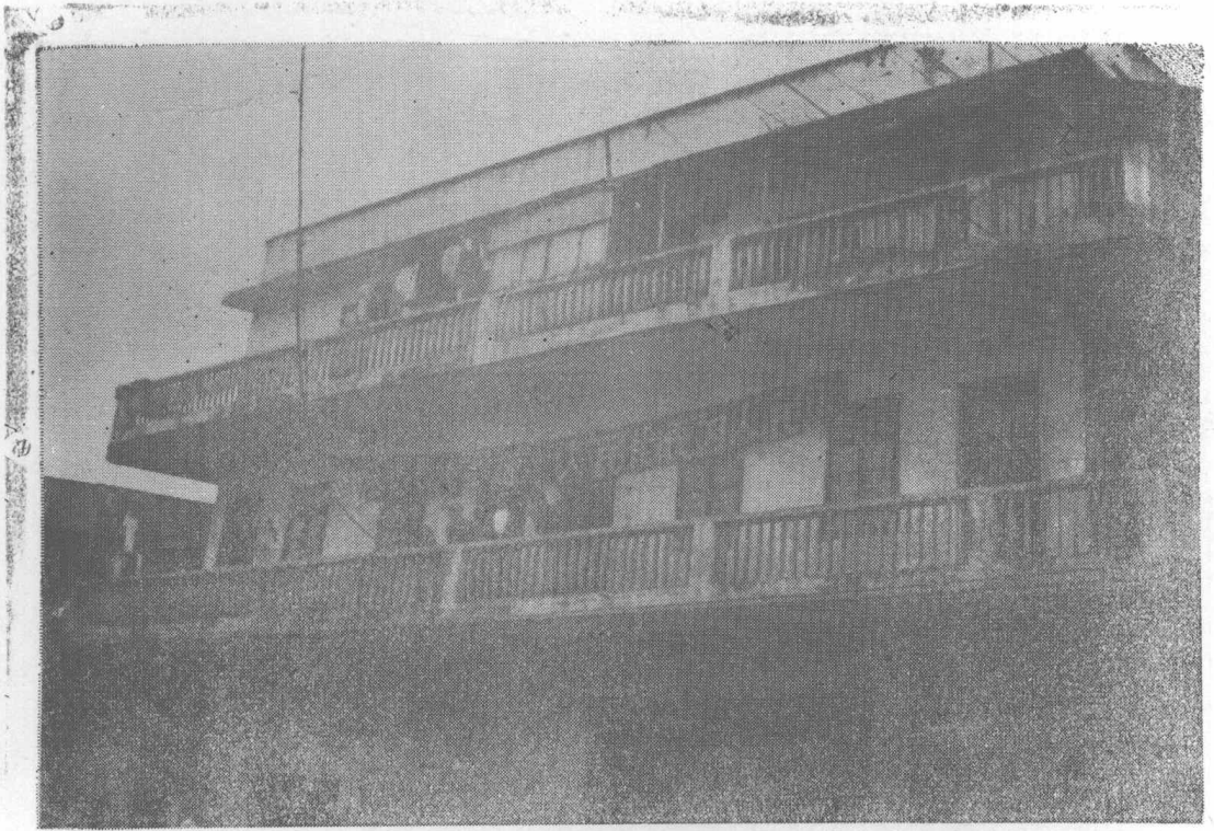
⑫ ↑ 六都搬运站办公楼
