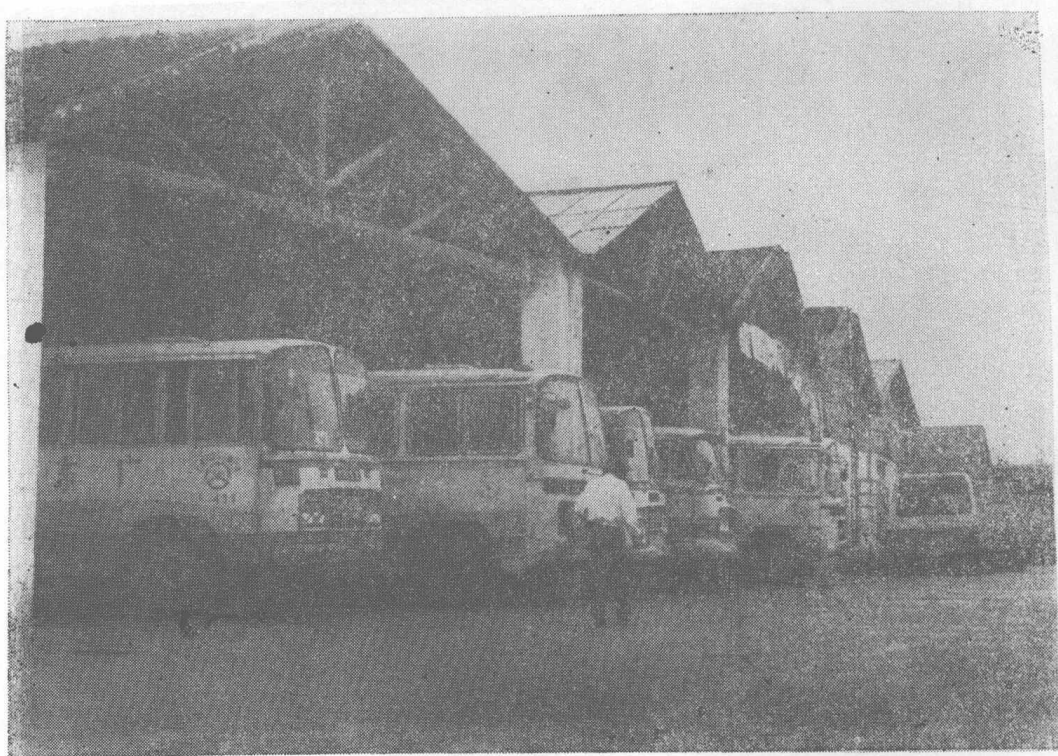
⑮ ↑ 县车站汽车修理厂车间
