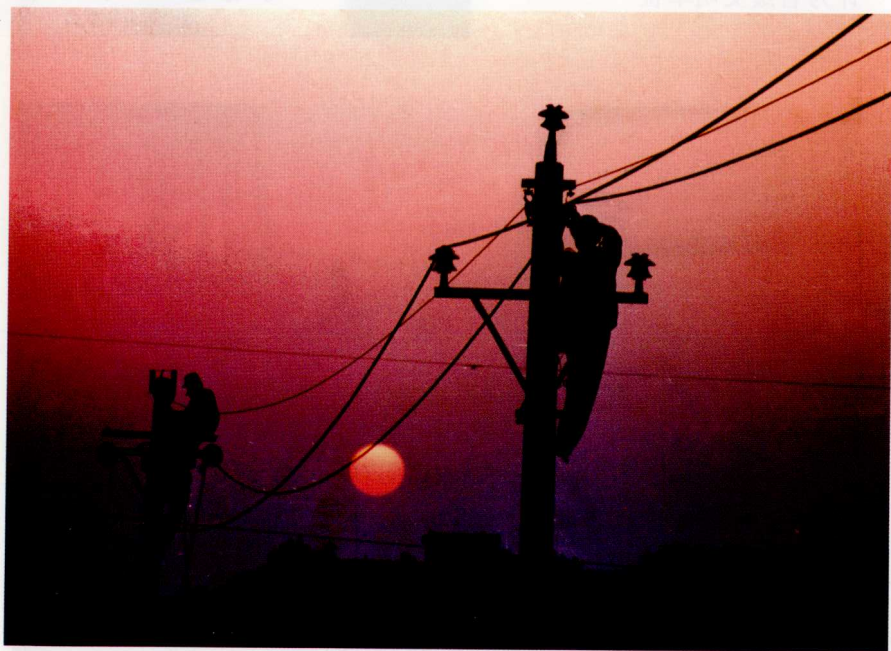
农村电网改造施工现场
