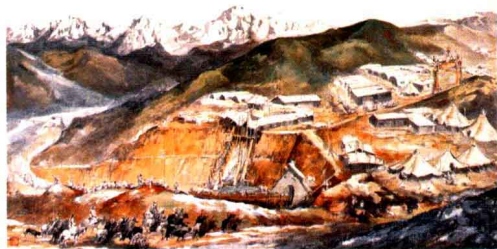
高原铁路建设工地
