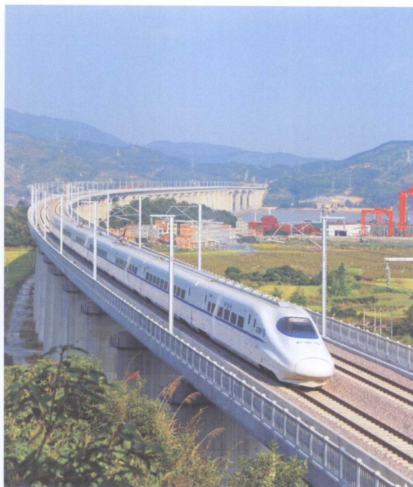
白马河特大桥
