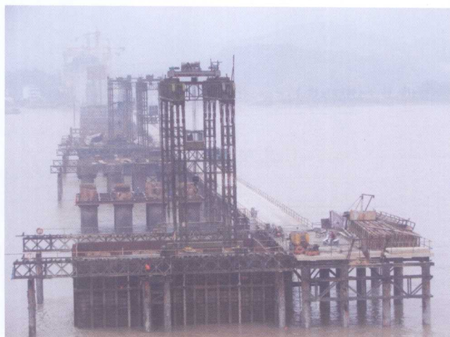
水上基础施工
