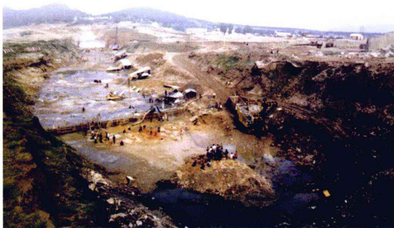
机械化开挖基坑
