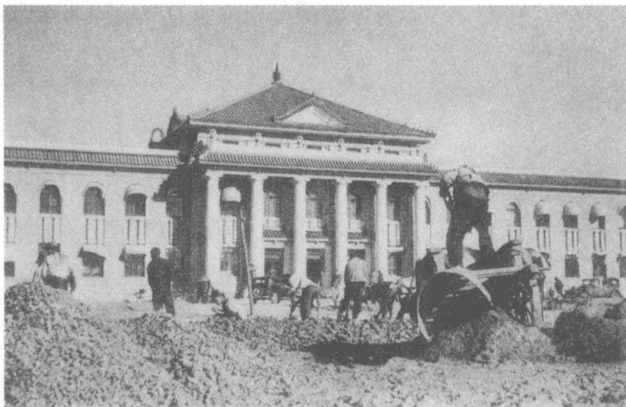
▼ 建设中的伪满新京
