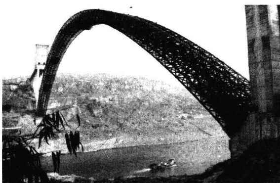
图 1-19 万县长江大桥劲性骨架施工
