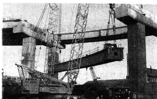
图 1-12 预制安装法施工
