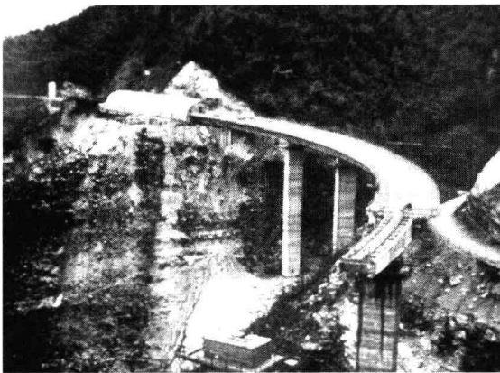
图 1-15 顶推施工法
