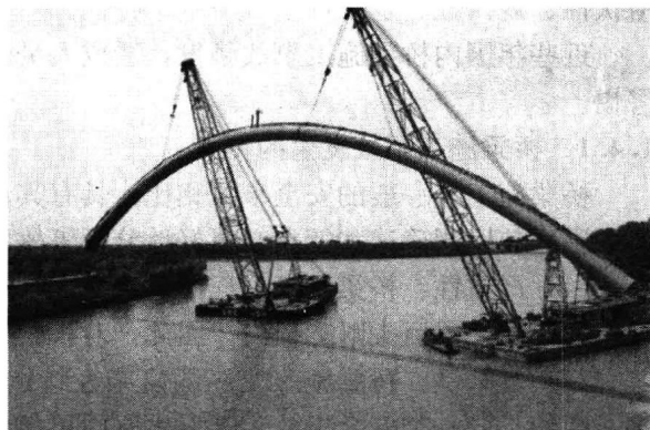
图 1-18 浮吊架设法
