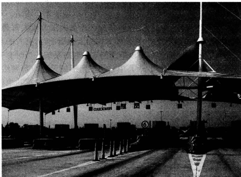
图 1-5 高速公路枫桥收费站破坏图
