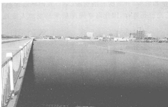
图 1-3-5 秦皇岛市滨海桥梁下游筑橡胶坝,阻挡涨潮海水进入桥下,减轻结构腐蚀
