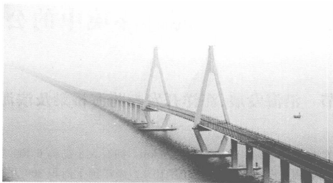
图 1-2-1 杭州湾大桥通航孔与非通航孔
