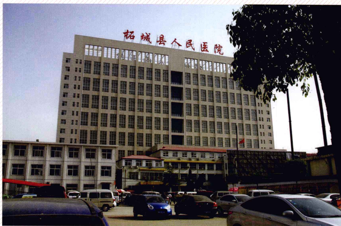
2011年7月投入使用的县医院综合病房大楼
