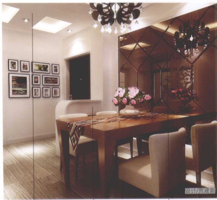
石膏板造型吊顶
