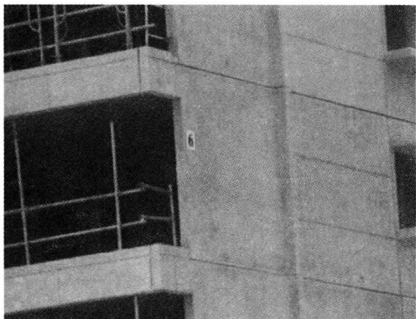
图 1-3 新加坡政府组屋预制混凝土外墙
