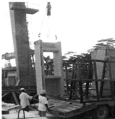
图 1-4 预制混凝土构件的卸装
