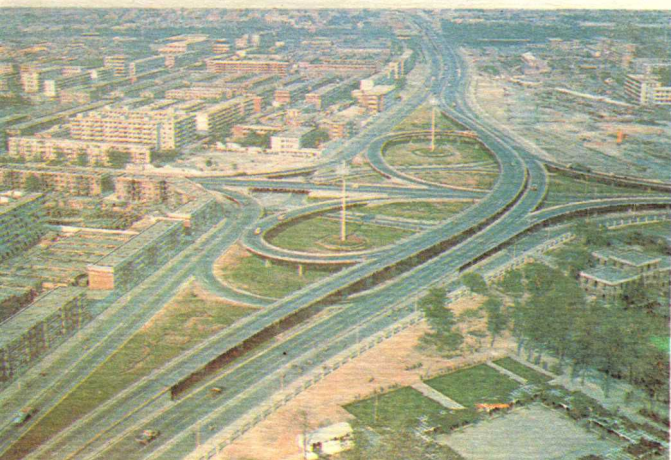
天津的公路立交桥
