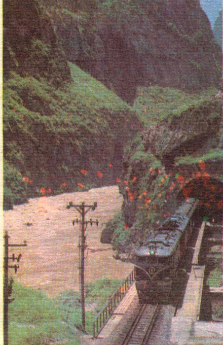
在成昆线上穿过隧道的火车
