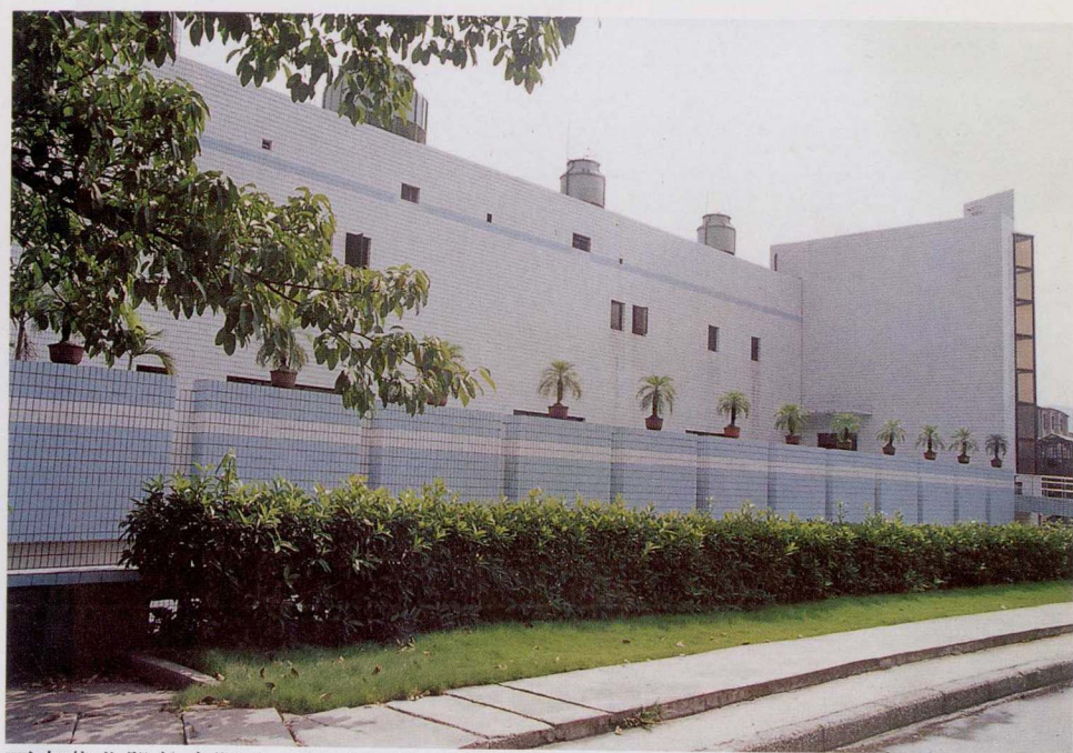
西南药业股份有限公司新建的凉干车间。
