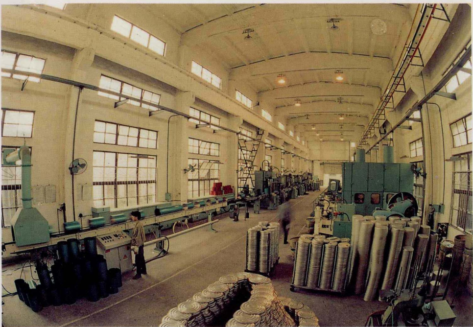
重庆三峡油漆股份有限公司生产车间。
