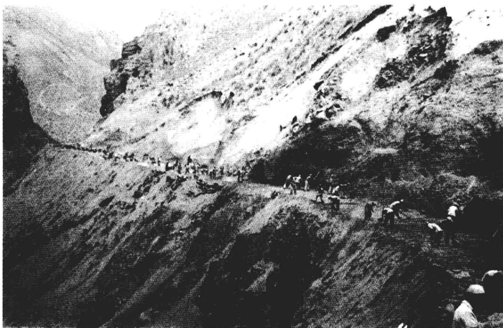
正在修筑的昆仑山中公路。
