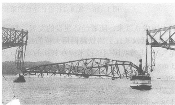
图 1-14 魁北克桥建设过程中的两次事故
