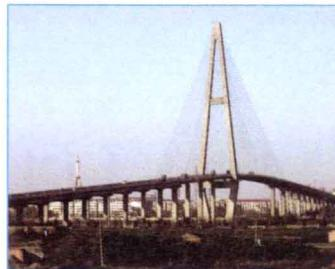
亚洲最大的独塔斜拉桥位于我国天津海河西侧。主塔高一百六十八米，正桥跨度长三百一十米，全长二千六百五十米。
