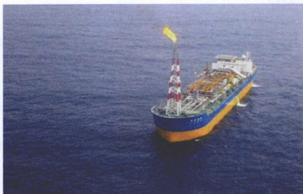
图 1-2 “南海奋进”号 FPSO
