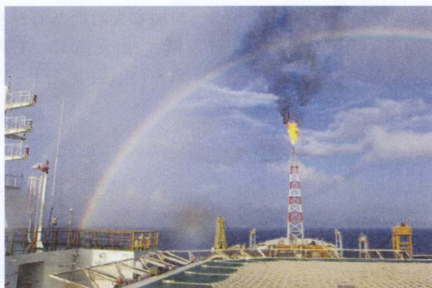
图 1-3 未装备 LPG 回收系统的火炬燃烧状况
