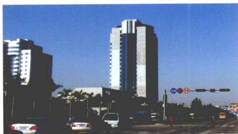
大贸公司建设的龙岗建设大厦
