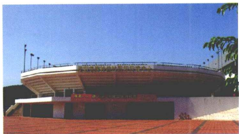
大贸公司建设的龙岗自行车赛馆
