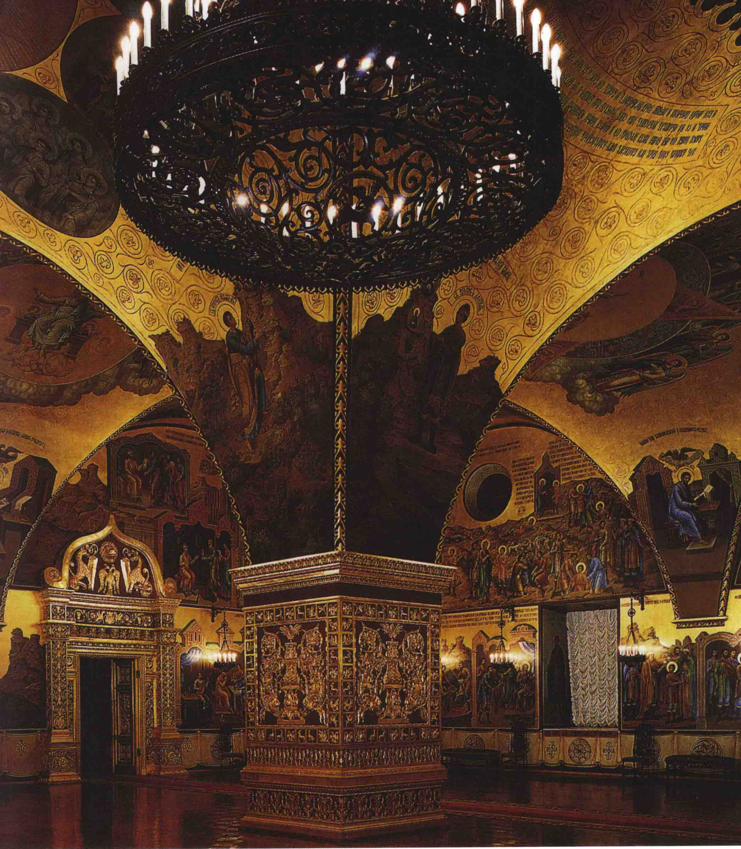
图 III-3 莫斯科 “棱面宫”。二层大厅（沙龙），内景（拱顶支在中央方形柱墩上）
