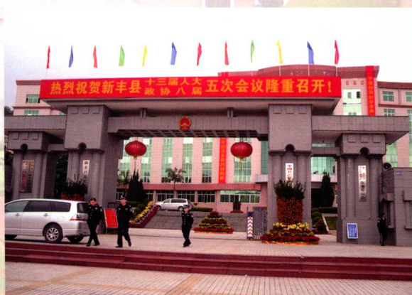
新丰县委、县政府办公大楼正门
