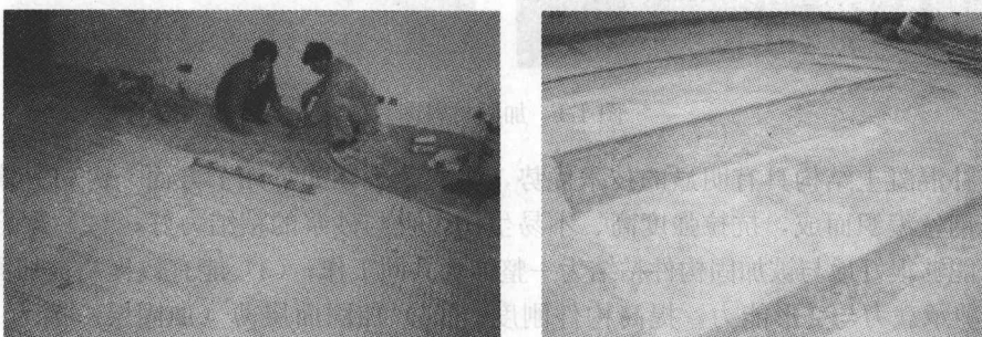
图 1-3 方兴宾馆楼板加固
