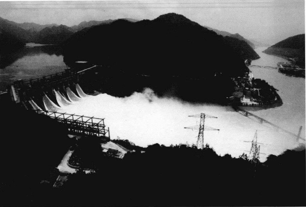
新安江大坝全景图
