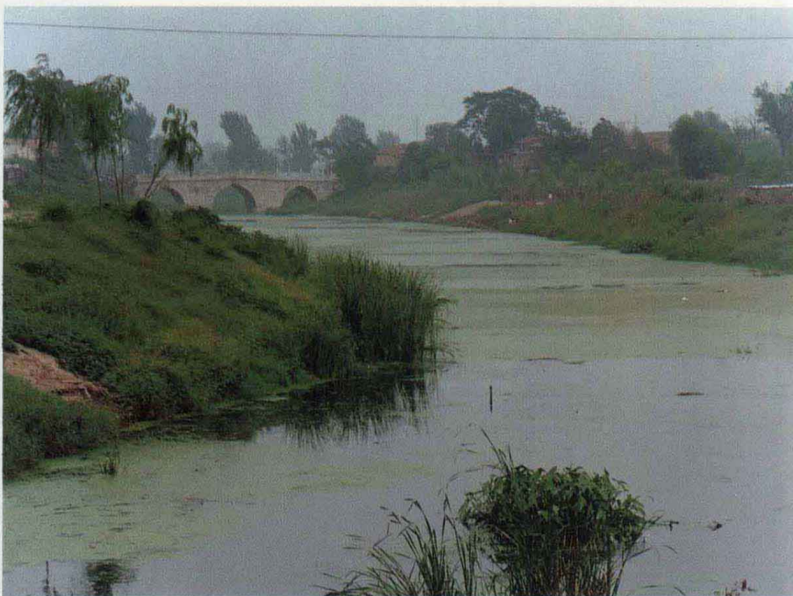
5、通州台湖镇辽代“萧太后河”遗址
