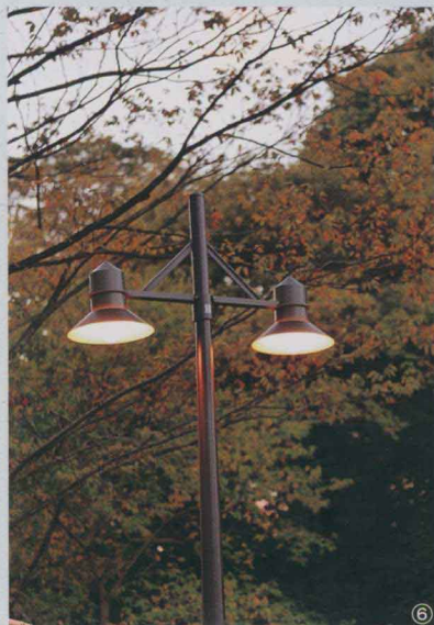
自行車停車場區配置 HID 70W 的雙燈式路燈，高度設定以不被樹木遮住燈光為準。
