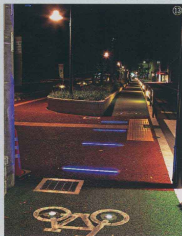
路口附近 為提高行人穿越道的安全性，以藍色線形發光二極管指示燈來提醒自行車減速。
