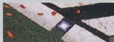
自行車停車場 車道和停車場的交界處以發光二極管指示燈（LED Indicator）明確顯示，促使停車整齊。
