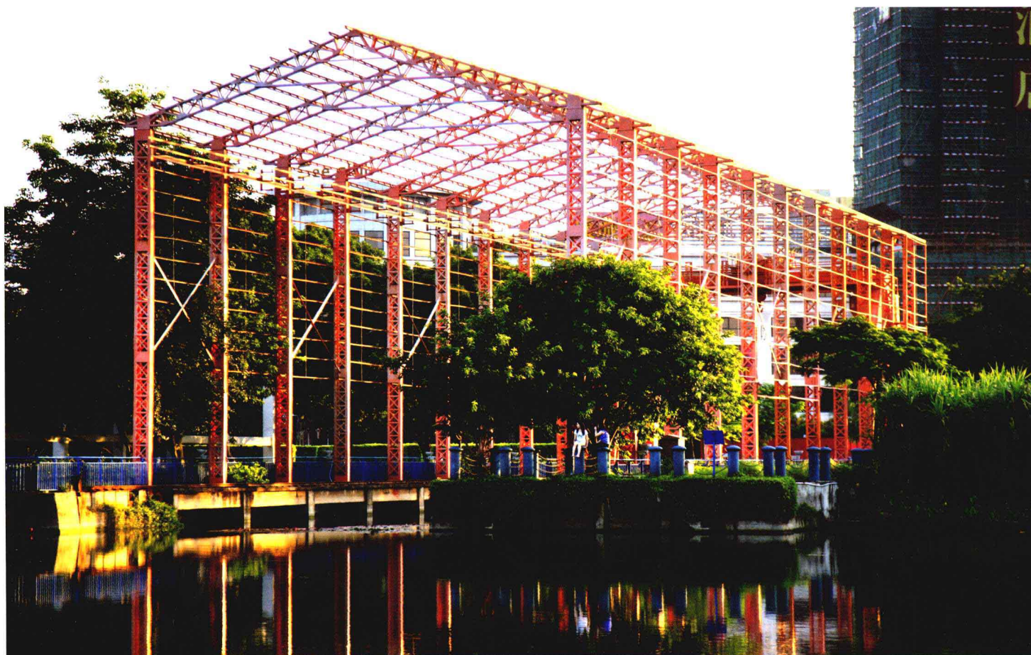
原工业厂房的钢架结构,中山岐江公园,2001年,土人景观设计。 俞孔坚通过再利用途径,保护了普通的工业遗迹。
