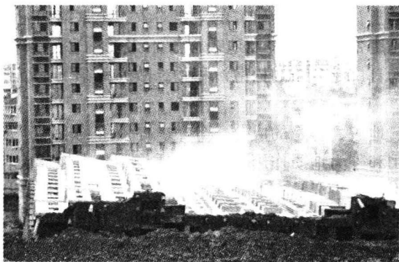
图0-3 上海莲花河畔景苑小区倒塌建筑
