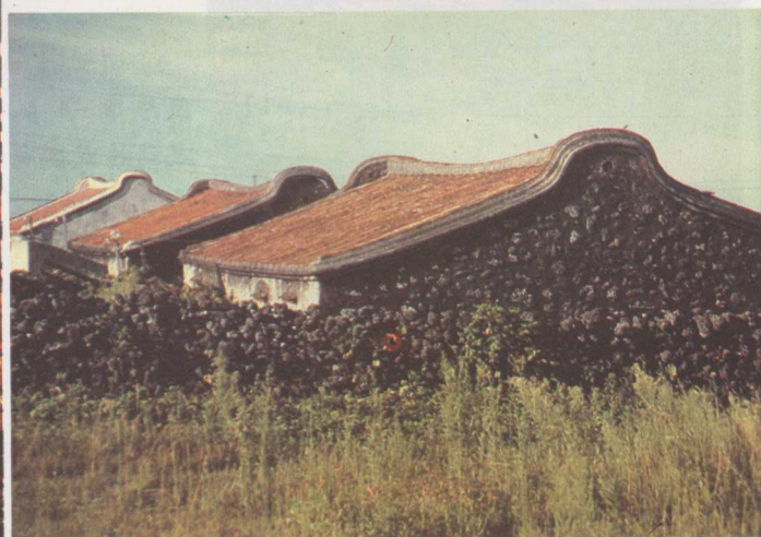
▲(17) 澎湖的硧砧（珊瑚礁石）石牆屋。
