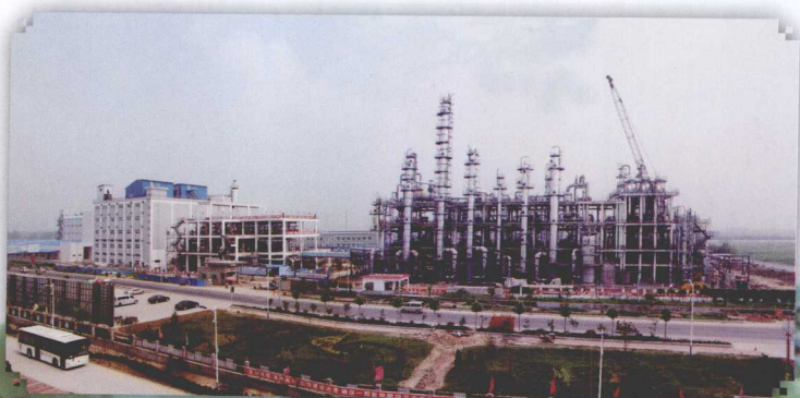
正在建设的聚甲醛项目
