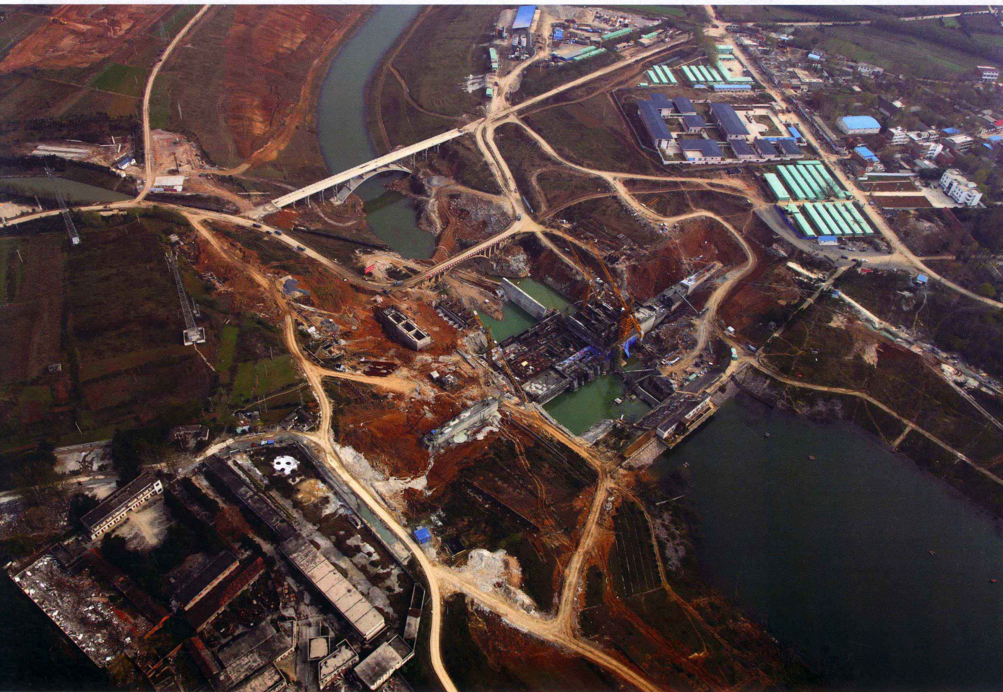
渠首建设全貌。 供稿 / 南宣
