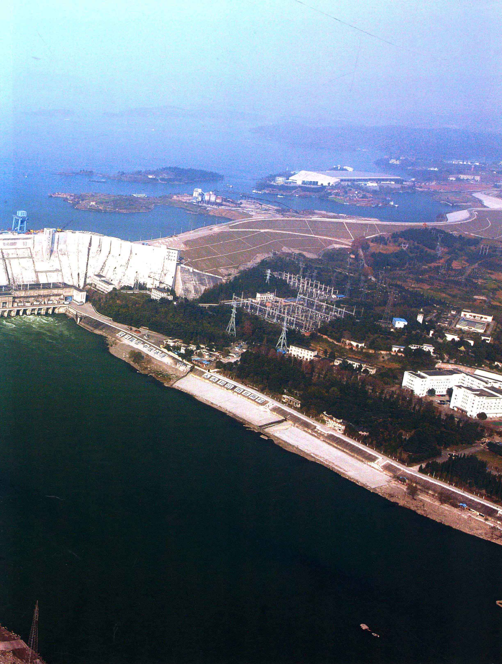
丹江口大坝经过7年多的加高培厚，已由原来的162米加高到176.6米，全线达到设计高程。 摄影 / 刘铁军
