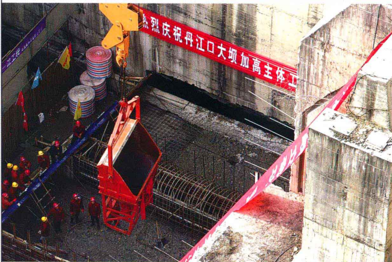
2005年11月25日，丹江口大坝贴坡加厚第一仓混凝土浇筑。 摄影 / 潘熙
