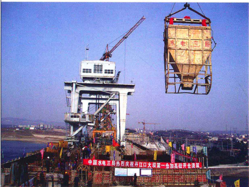
2007年3月7日，丹江口大坝加高第一仓混凝土开盘浇筑。 摄影 / 潘熙
