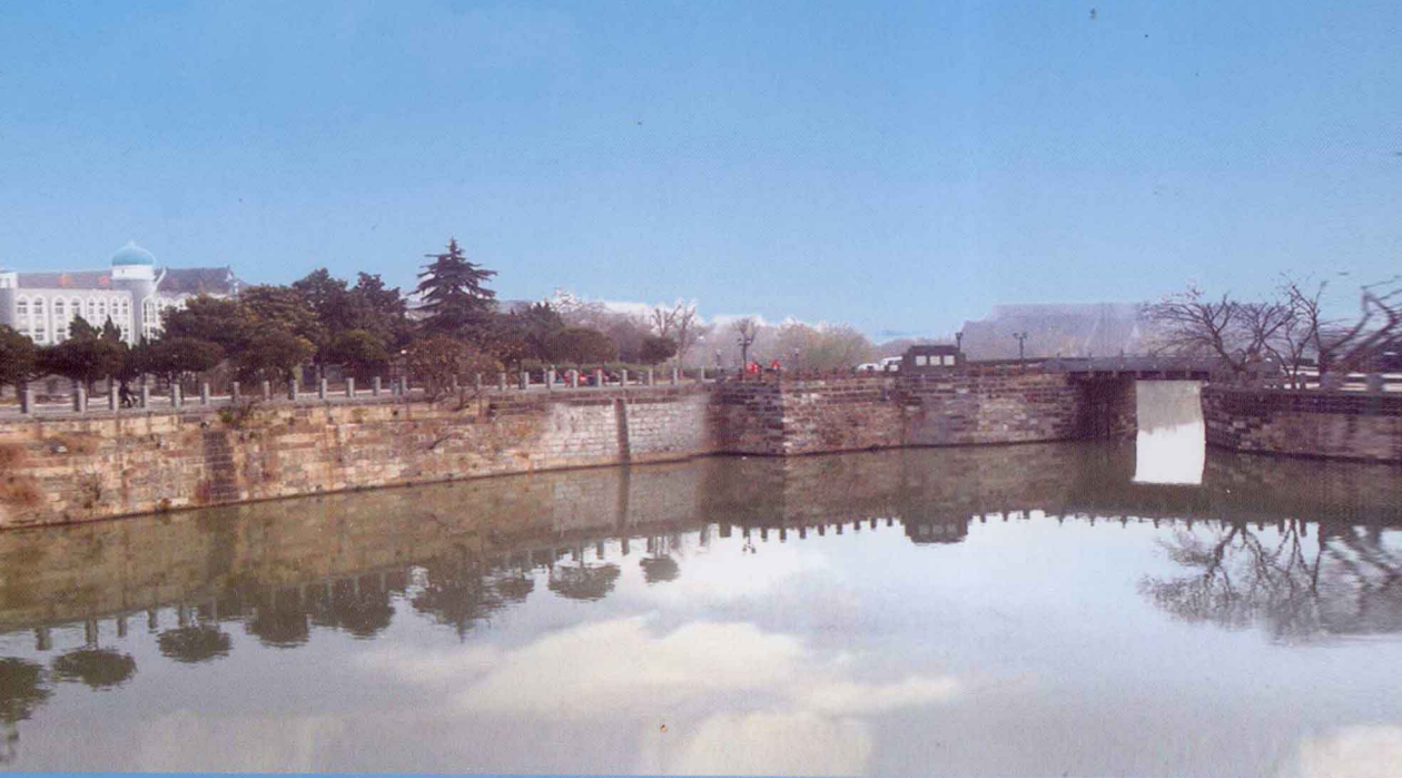
◆清江闸（正、越闸）
