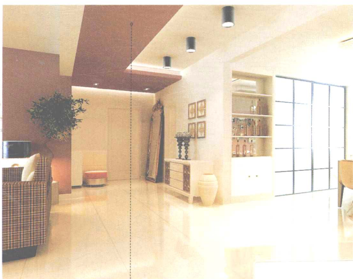
石膏板造型+乳胶漆
