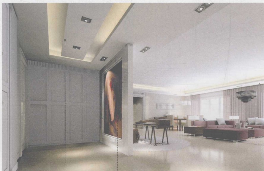
.. 石膏板吊顶 .. 轻质隔墙+装饰画
