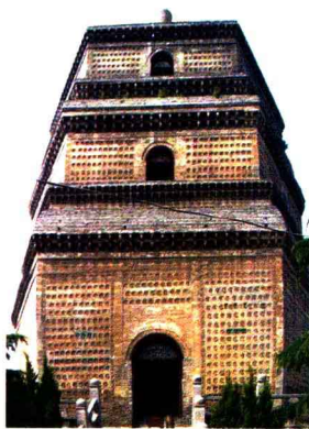
开封北宋天清寺塔(繁塔)
